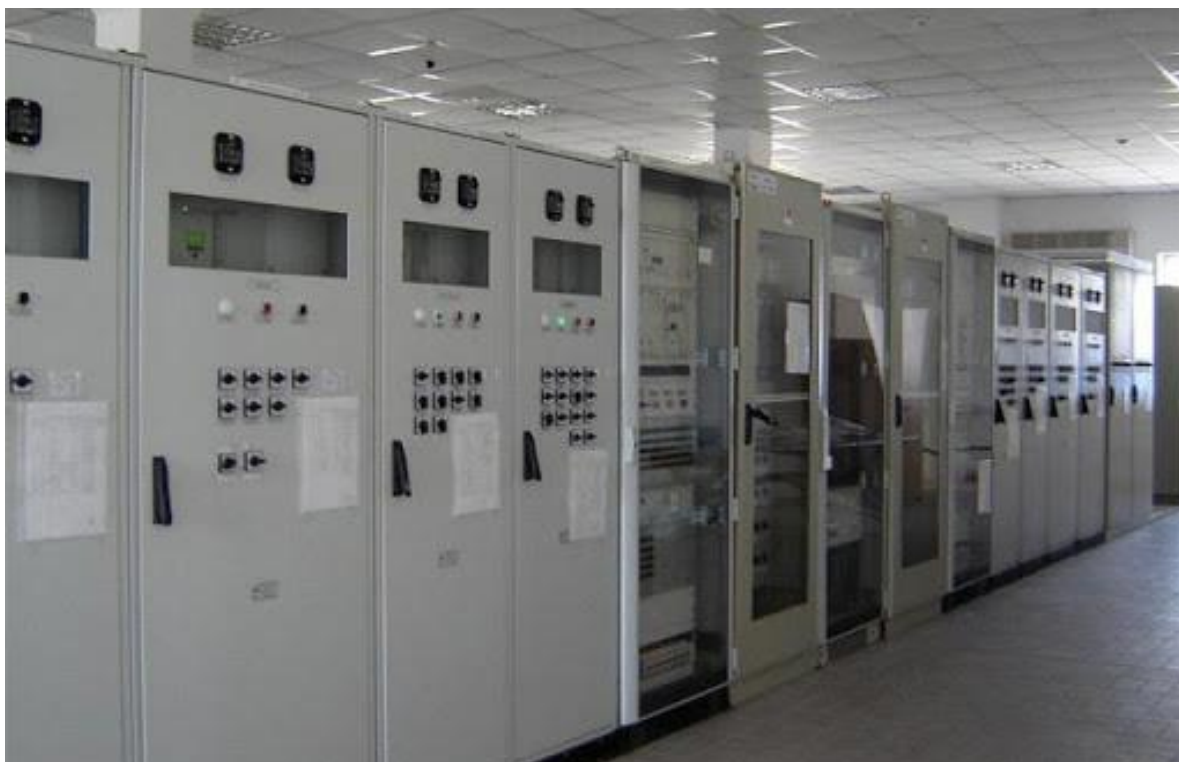
Рисунок 3 – Пример, как могло бы выглядеть оборудование комплектов РЗА ОПУ-330 кВ
